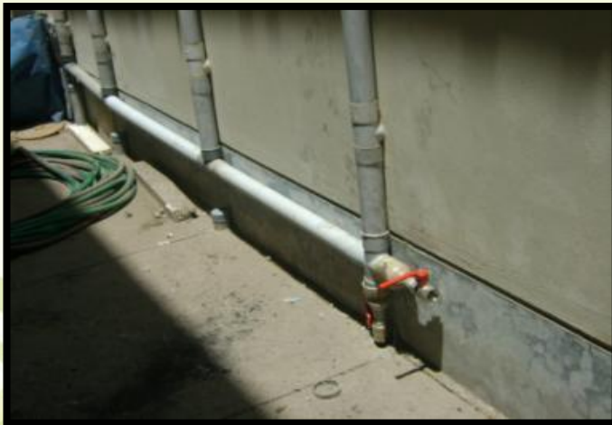
Modificación de las cañerías de desagüe
