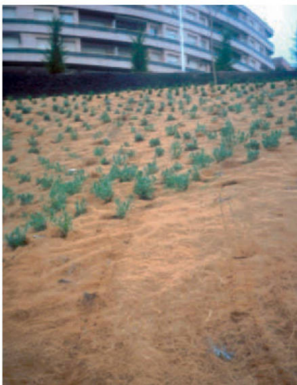
Ajardinamiento en ladera utilizando un geotextil que protegerá el suelo de forma temporal contra la erosión, mientras se establece la vegetación. En unos tres años el geotextil se biodegrada, siendo ya innecesaria su protección en aquel momento (Lleida, Cataluña, España). J. Porta.
