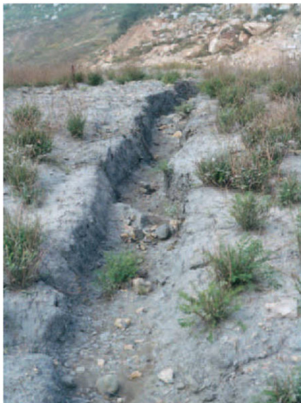
Degradación de una escombrera de carbón al no haber diseñado medidas eficientes de control de la erosión. Barcelona, Cataluña, España.
