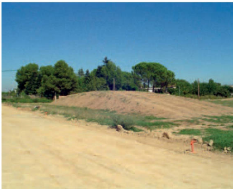
Previamente a proceder a abrir una nueva calle se retiró el material edáfico (capaceo), reservándolo, tal como aparece apilado en forma de artesa invertida, para redistribuirlo posteriormente en las zonas a ajardinar (Lleida, Cataluña, España).
