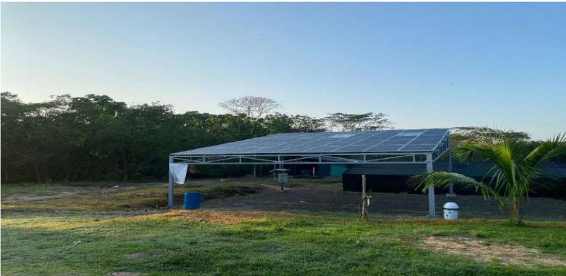
Panel solar con sistema fotovoltaico como fuente de energía para el sistema de bombeo para riego
