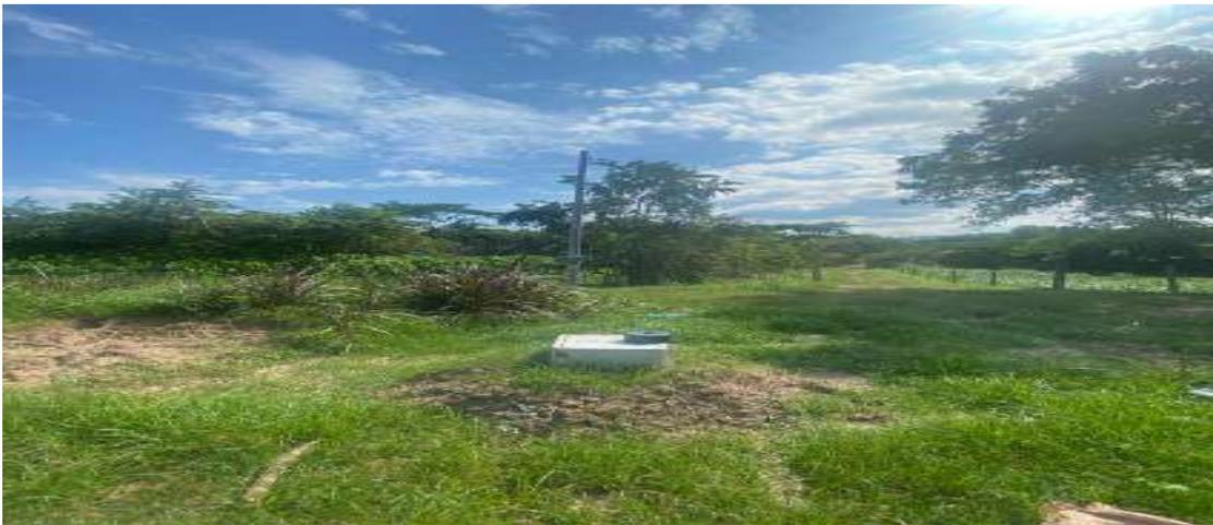
Pozo de agua terminado y con el poste de concreto para la conducción de línea eléctrica aérea.
