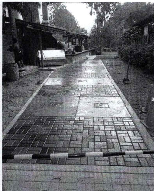
Construcción de vereda en zona de
