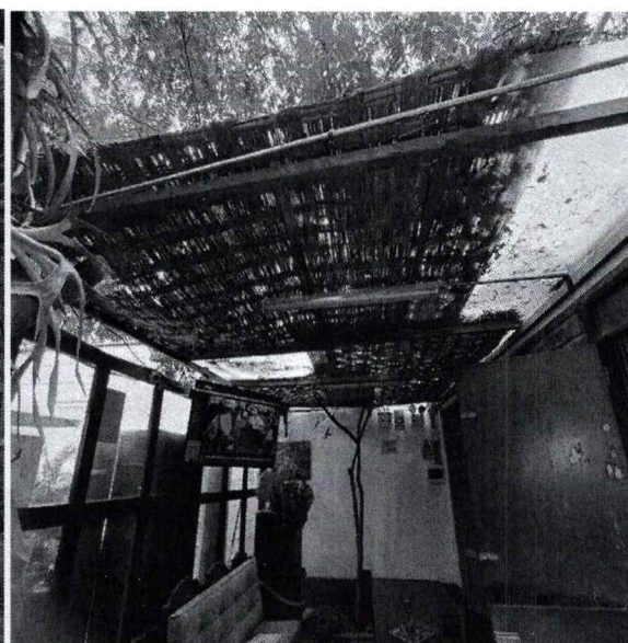
Cambio de techo en la oficina ecológica
