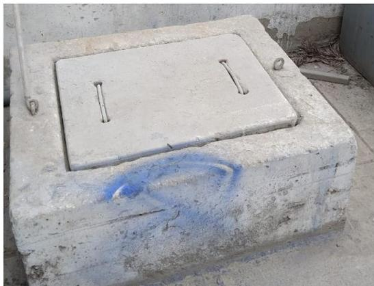
Figura 2. Caja de ingreso y salida de agua sellado dentro del Centro de Investigación de Hidroponía
