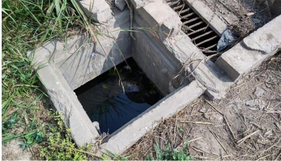
Figura 3. Caja 1 de entrada y salida de agua dentro del PIPS de maíz
