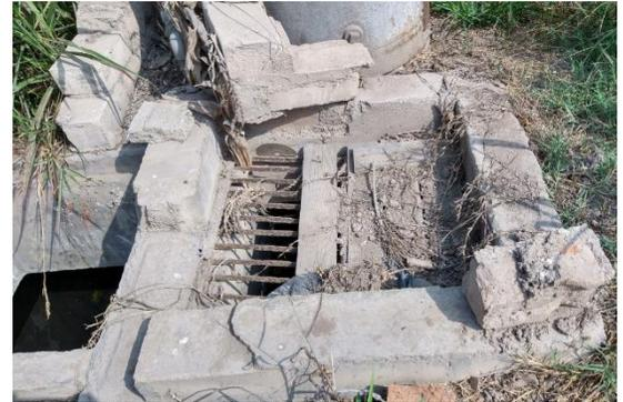
Figura 4. Caja 2 de entrada y de salida de agua dentro del PIPS de maíz
