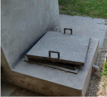
**Figura 5. Caja de entrada y salida y agua tapado cerca al Lab. de agronomía**
