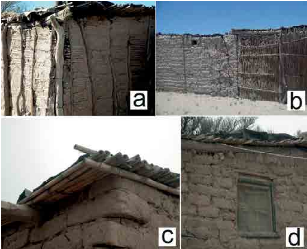
Figura 4. Materiales del espacio cerrado de la casa habitación: a) muro de quincha; b) muro combinado de quincha y adobe; c) detalle de cubierta y materiales empleados y d) ventana con dintel aislado y cierre liviano de nylon sintético por el exterior.
