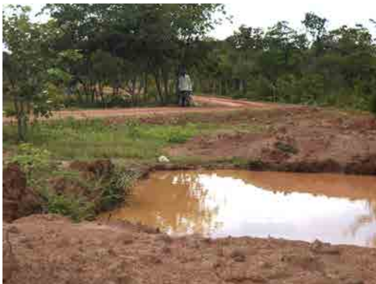
Figura 5. Aspectos gerais da estrada: bacias laterais de captação
