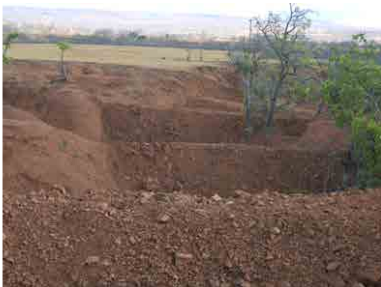
Figura 2. Seccionamento de voçorocas com a construção de pequenas barragens
