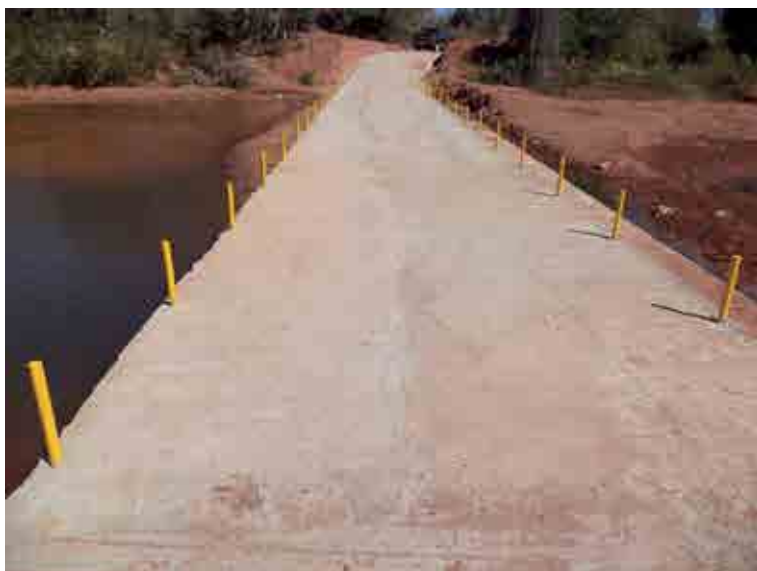
Figura 6. Aspectos gerais da estrada: passagem molhada construída no Riacho Sucuriú que serpenteia a “estrada ecológica”.
