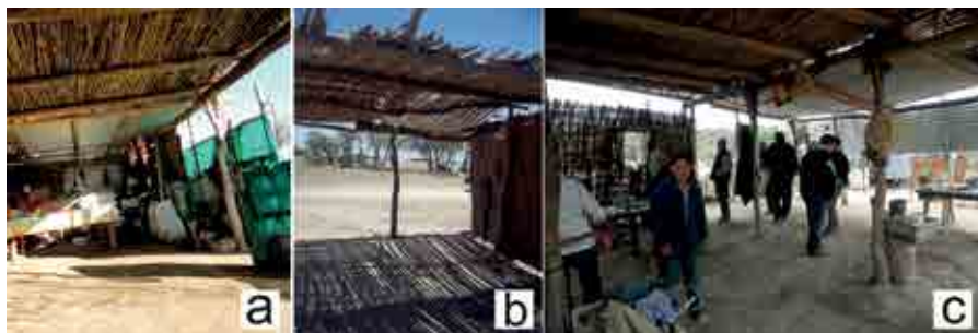
Figura 5. El espacio semicerrado de la casa habitación: a) elementos de la vida diaria en el espacio semicerrado; b) uso de caña para la cubierta y c) combinación de chapa acanalada y caña.
