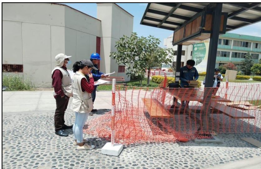
Gestión para la instalación de 10 estaciones fotovoltaicas.
