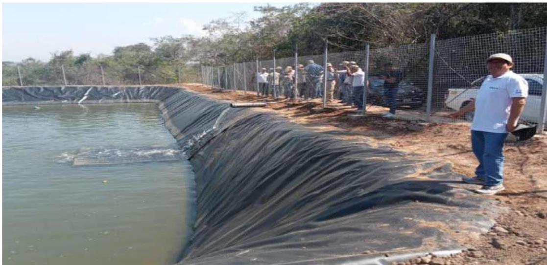
Reservorio de 1200 m<sup>2</sup> de 35x19x35mts para riego
