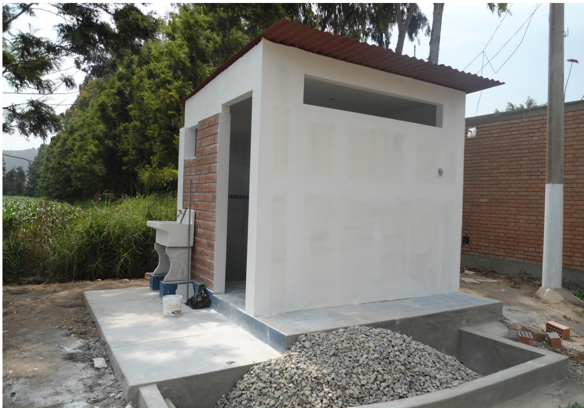
14. Colocación de drywall y techo en fibraforte, totalmente concluidos.
