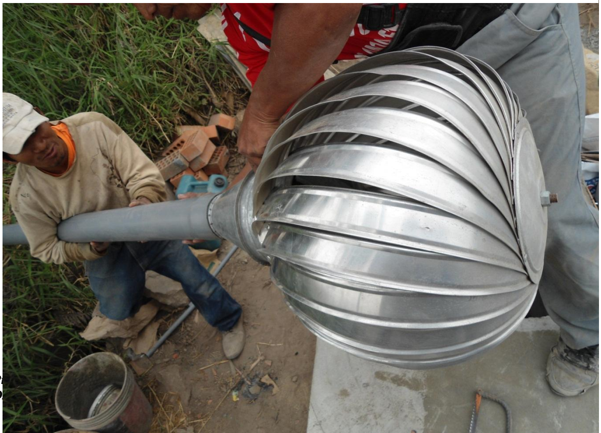
13. Colocación de extractor eólico en la cámara que se utilizará inicialmente.
