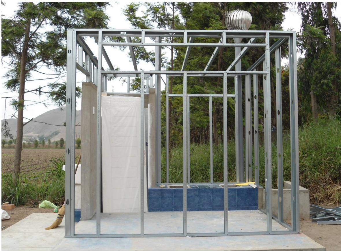
15. Instalación de rieles para muros de drywall
