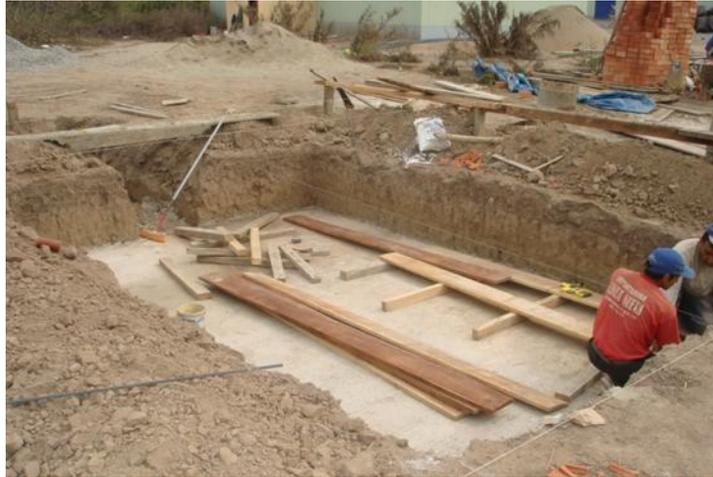
**Fig.N° 7: humedal construido en etapa de curado**
