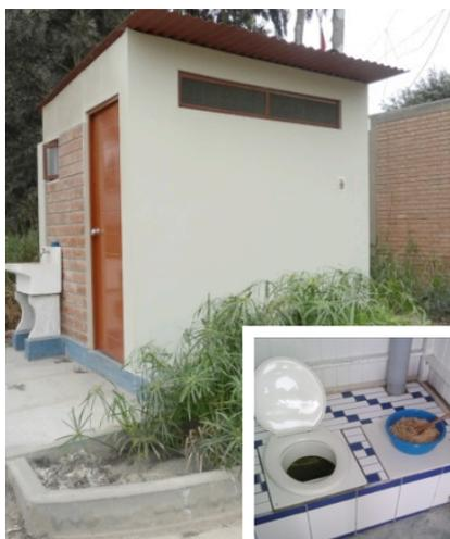
Baño Ecológico Seco, separación de orinas y tratamiento de aguas grises con humedales construidos
