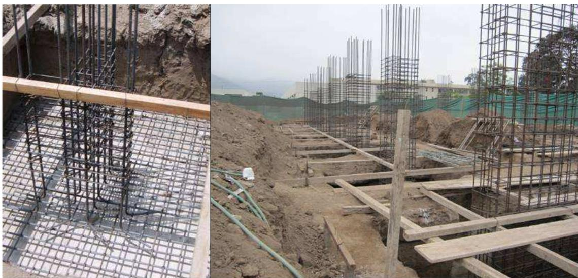
**Foto N° 15.7: Vista del levantamiento de las columnas y placas del modulo 8 – III Etapa**
