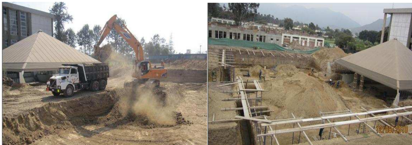
Foto N° 15.4: Excavación masiva de sótano y zapatas de los muros de contención
