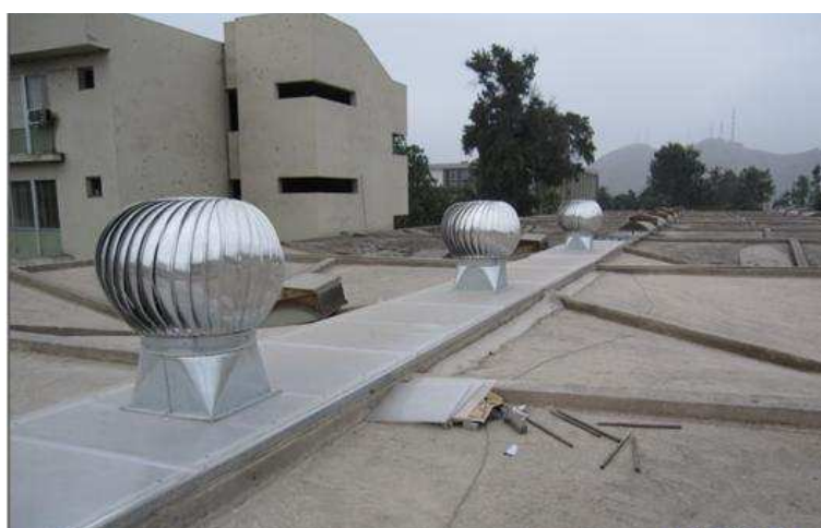
Foto N° 15.3: Equipos extractores eólicos MOD EO-60, ubicados sobre los techos parabólicos del Laboratorio de Hidráulica y Mecánica de Fluidos.
