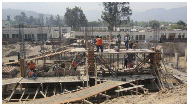
Foto N° 15.6: Rampas de acceso para vaciar las columnas de concreto armado del primer piso
