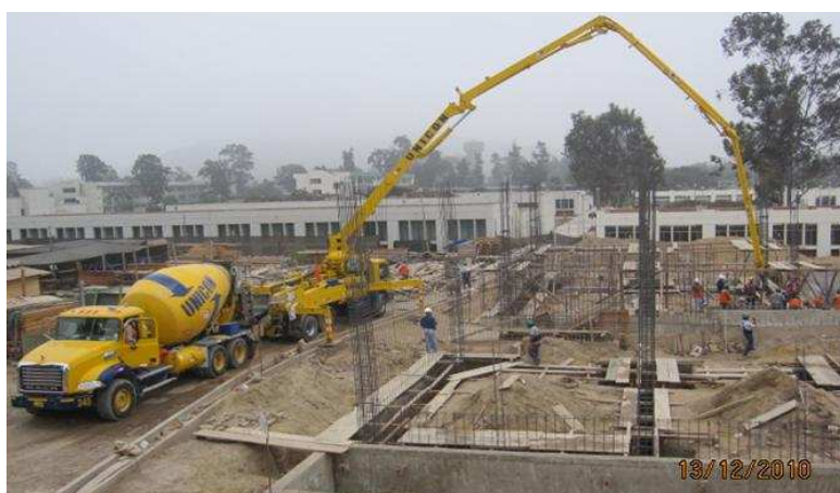
Foto N° 15.5: Camión concretero y bomba para vaciar las zapatas y vigas de cimentación del primer piso
