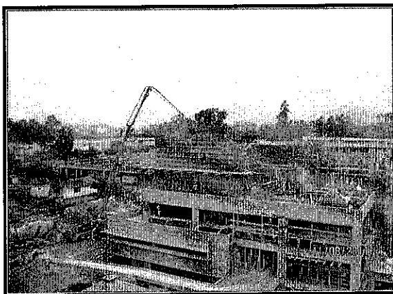
Foto N° 15.2: Vaciado de concreto f_c = 210 \text{ Kg/cm}^2 en columnas y tercer piso de la edificación
