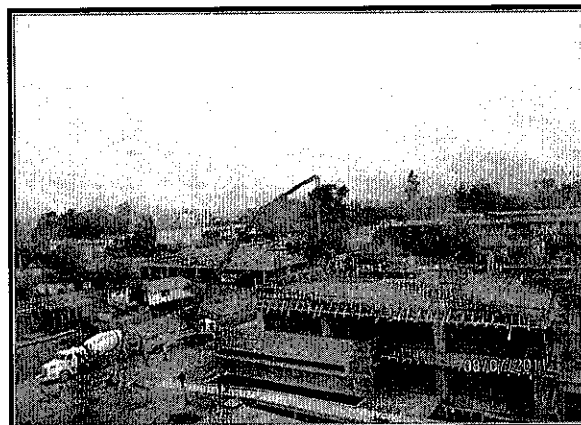
Foto N° 15.2: Vaciado de concreto f_c = 210 \text{ Kg/cm}^2 en columnas y tercer piso de la edificación
