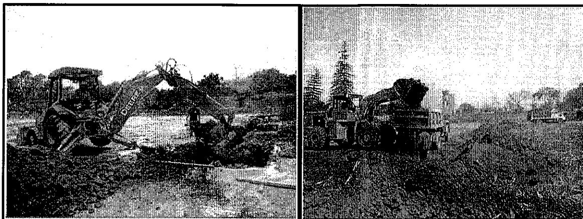
Foto 15.6: Limpieza del area y excavación de zanjas de cimentación
