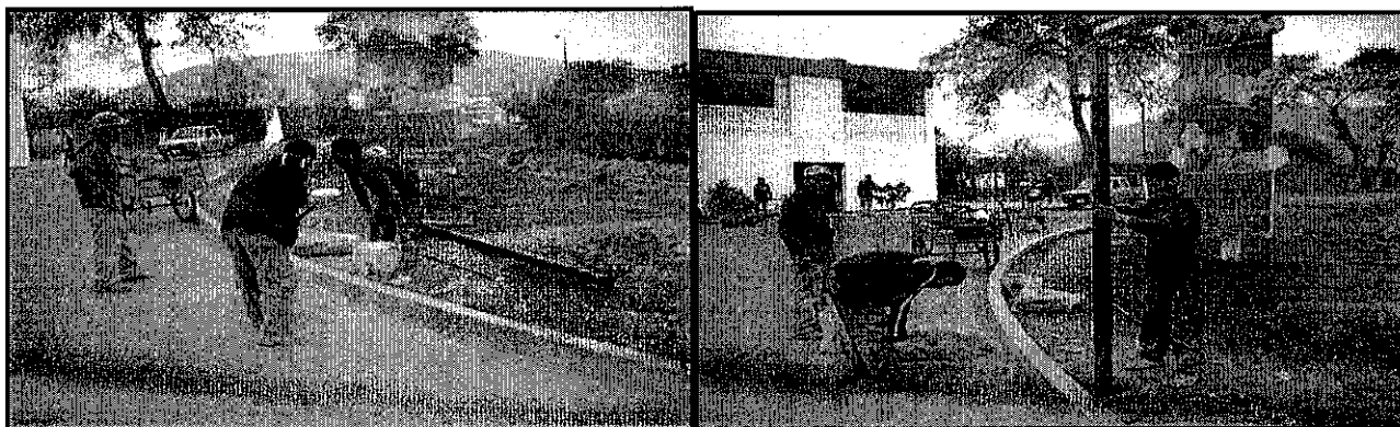
Foto 17.5: Instalación de letreros para señalización
