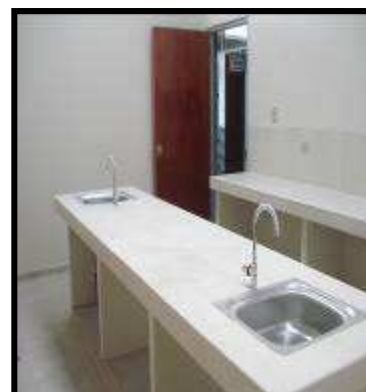
Foto 14.4: Mesas de Concreto con Acabado de Porcelanato y con Lavaderos de Acero Inoxidable
