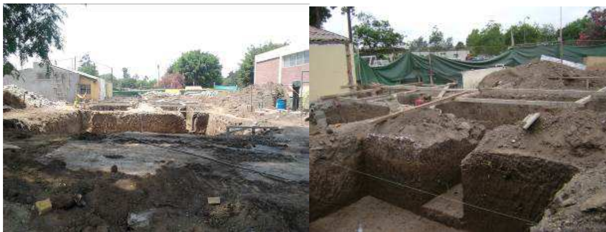
Foto 14.12: Demoliciones ejecutadas perfilado de zanja
