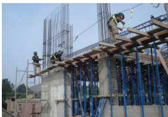
Foto 14.9: Colocaci3n de Armadura en Vigas de Primer Piso
