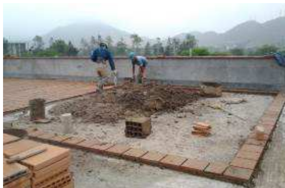
Foto 14.8: Colocaci3n de Ladrillo Pastelero en azotea, utilizaci3n de winche el3ctrico para trasladar tierra y agua, realizaci3n de la mezcla.
