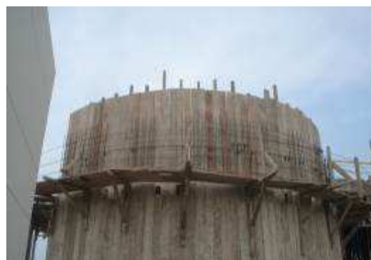
Foto 14.10: Encofrado de Placas Circulares
