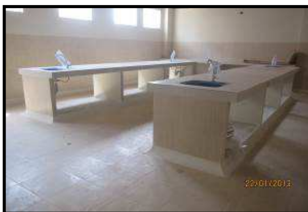
Foto 14.6: Mesas de Concreto con Acabado de Porcelanato y con Lavaderos de Acero Inoxidable
