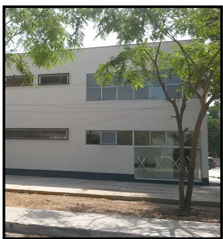
Foto 13.7: Vidrio templado en las ventanas y mampara de la obra
