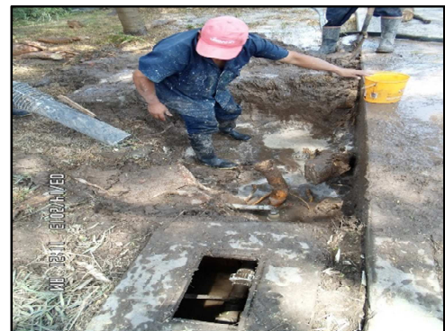
Foto 15.2: Reparar tuberías de agua rotas por raíces de los árboles, en las zonas de: Oficina de Investigación
