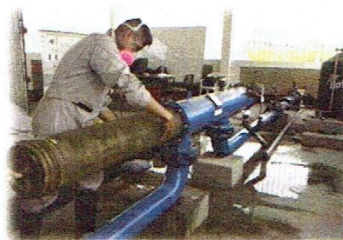
Mantenimiento del sistema de filtrado de riego por aspersión
