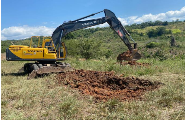
Excavación del Primer reservorio en el potrero P11.
