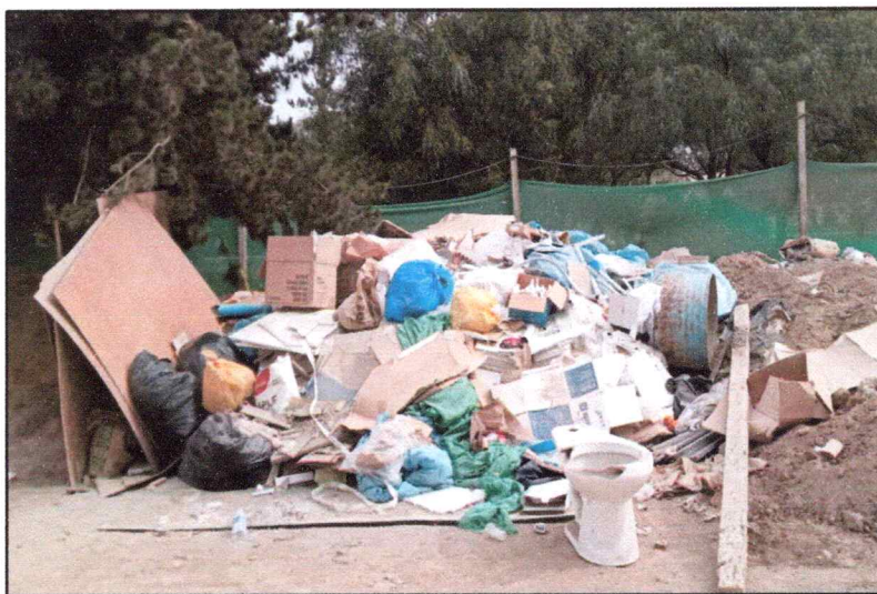
Imagen 1. Excedentes de obras del proyecto “Ampliación de los servicios académicos y administrativos de la facultad de economía y planificación”.
